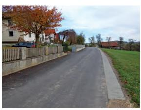
Bankettstabilisierung mittels Bankettplatten
