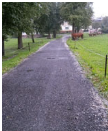
Mit Asphaltrecyclingmaterial wurde der Wirtschaftsweg Witraun wieder instandgesetzt
