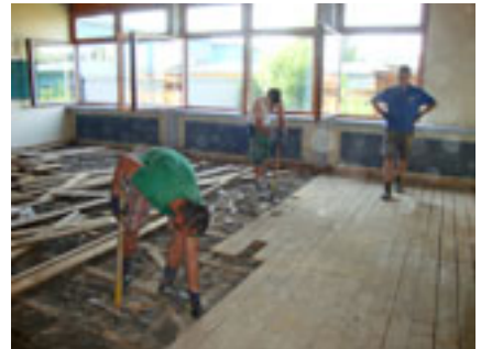
Der Boden in der Volksschule musste bis zur Bodenplatte abgetragen werden
