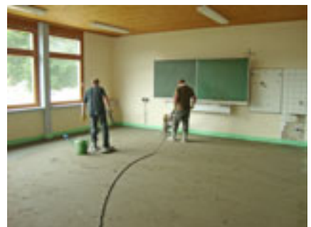
Der gesamte Fußbodenaufbau wurde erneuert, im Bild die Estricharbeiten
