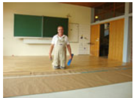
In allen vier Räumen wurde ein neuer Parkettboden verlegt
