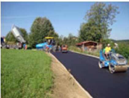
Nun wurde der Römerweg nach vielen Jahren im Rohbau asphaltiert
