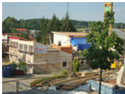
Die Umbauarbeiten am Kindergarten laufen auf Hochtouren
