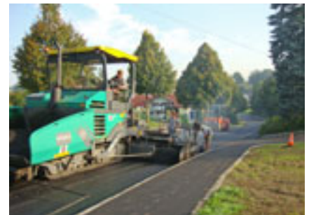
Auf die Bründlallee wurde eine neue Asphaltdecke aufgetragen
