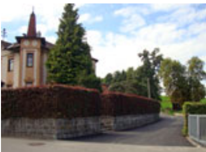
Auch ein Teilstück der Theodor-Wimmer-Straße erhielt eine Neuasphaltierung
