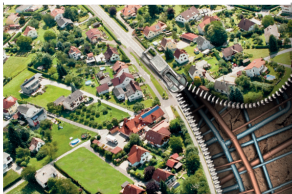
Versteckt unter Straßen und Grundstücken befindet sich ein dichtes Netz an Kanal- und Wasserleitungen
