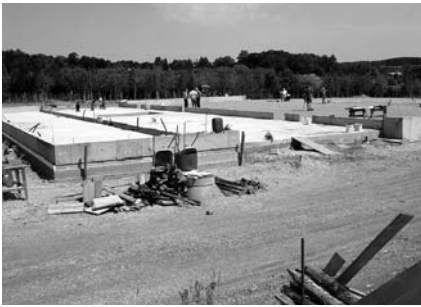
Bereits in vollem Gange ist die Errichtung des Gründerzentrums
