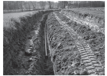
Der Bau der Moarhofstraße mit Verlegung der Wasserleitung und der Straßenbeleuchtung - vom Gemeindebauhof in Eigenregie durchgeführt.
