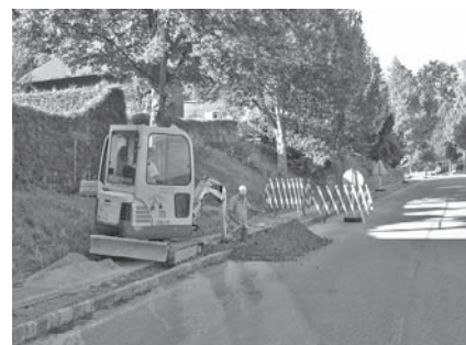
Grabungsarbeiten in der Bründlallee
