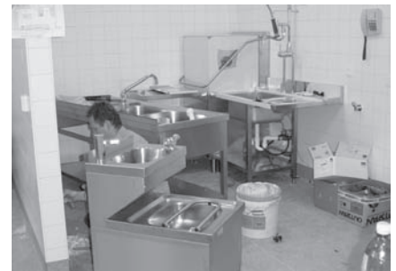
Färbelungsarbeiten in der Aula und Einbau der neuen Ausspeisungsküche
