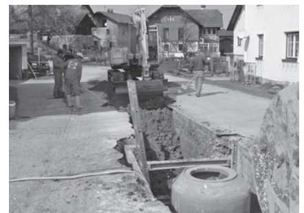
Die Kanalbauarbeiten in Brünning
