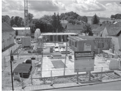
Auf insgesamt 2.596 m 2 entsteht das Geschäftszentrum mit Ortsplatz, Zufahrtsstraße und 35 Parkplätzen
