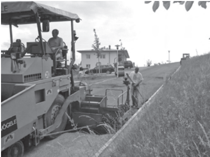
Die Asphaltierungsarbeiten im Siedlungsgebiet „Am Etlgrund“
