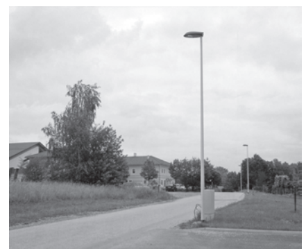
Die neu errichtete Straßenbeleuchtung im Betriebsbaugelände Moarhof
