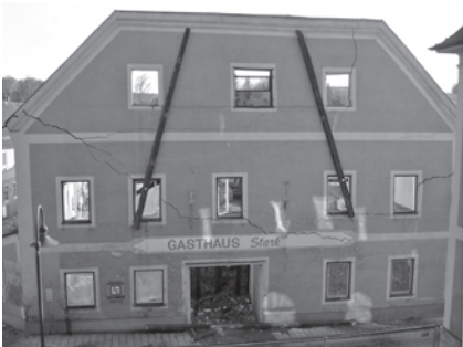
Der Abriss der Giebelmauer des ehemaligen Gasthauses Stöger
