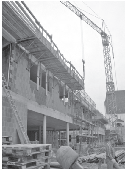
Der Rohbau des Geschäftszentrums ist fast fertig gestellt
