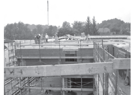
Das Aufbringen des Dachstuhles über den im südlichen Bereich gelegenen Wohnungen
