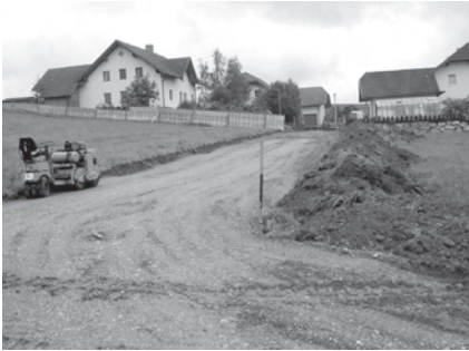
Die im Rohbau errichtete Straße am Würmerfeld
