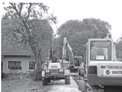
Der Kanal- und Wasserleitungsbau in Pausing
