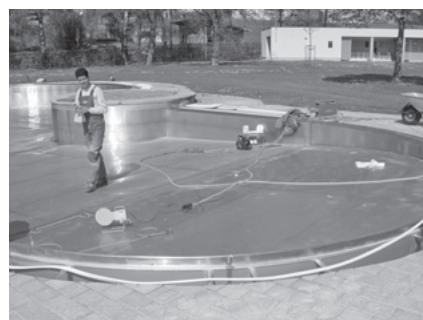
Das gesamte Nichtschwimmerbecken ist nun in Edelstahl ausgeführt
