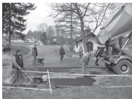
Die Asphaltierung des GW Brünning nach dem Kanalbau
