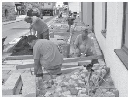
Die Pflasterung der Parkplätze entlang der Marktstraße durch die Straßenmeisterei
