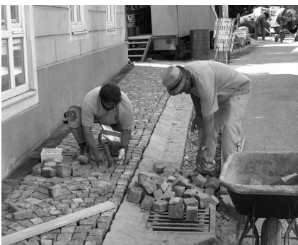
Die Straßenmeisterei Raab bei der Pflasterung des verbreiterten Gehsteiges
