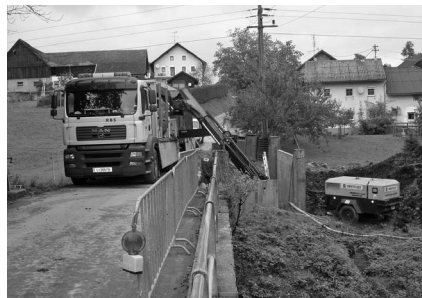
Bohrung unter dem Wiesbach zur Verlegung des Kanals in der Ortschaft Riedlhof
