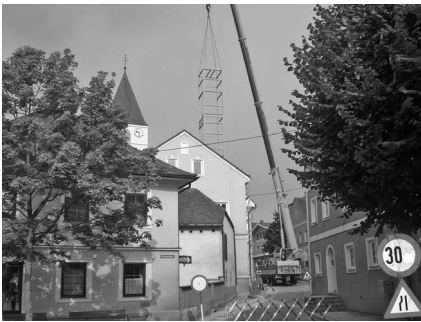
Mit einem Kran wurde die Stahlkonstruktion für den Liftschacht in das Gebäude gehoben
