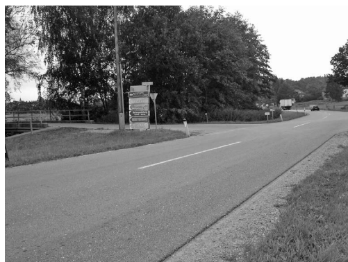
Hier soll der Linksabbiegestreifen auf der Brünninger Landesstraße entstehen
