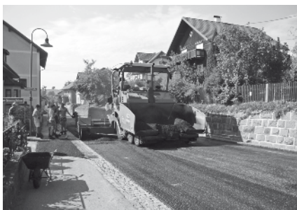
Ein Teil der Hauptstraße wurde neu asphaltiert
