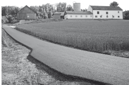
... als auch auf dem Güterweg Pausing wurde eine neue Asphaltdecke aufgetragen
