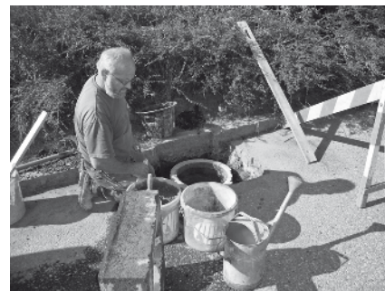
Bauhofvorarbeiter Johann Mayr beim Anpassen eines Kanalschachtes an die neue Höhe der Fahrbahn
