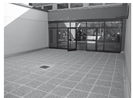
Für die Sanierung der Volksschulterrasse musste zur Gänze die Gemeinde aufkommen
