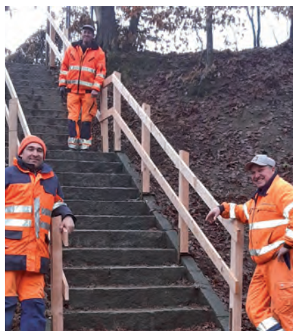
Tischler Fritz Seidl und seine Bauhofkollegen nach der Montage des Geländers in der Kellergröppe
