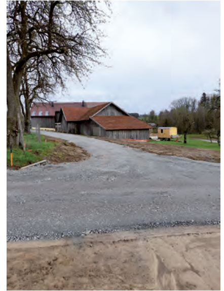
Der Güterweg ist im Rohbau fertiggestellt
