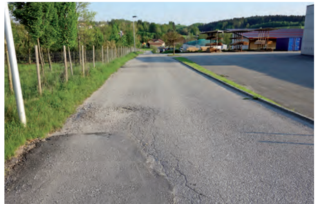
Ein Teilstück der GewerbestraÙe – im jetzigen Zustand
