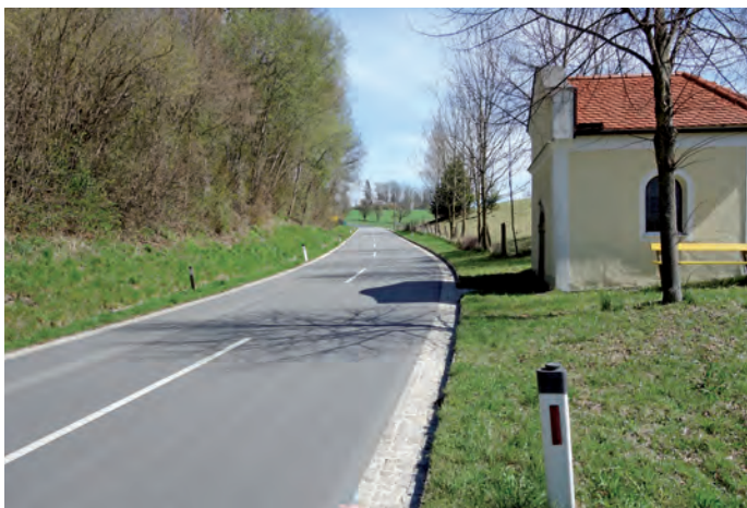
Die Errichtung des Gehsteiges bis zur Einmündung in der Kallhamer Landesstraße erfolgt in der 2. Jahreshälfte
