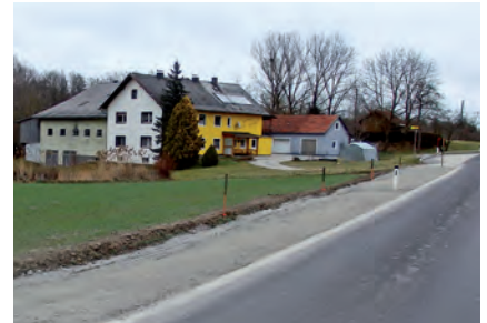
Vorläufig noch im Rohbau – der neue Gehsteig in Gautzham
