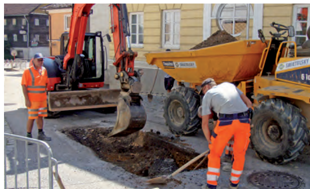
Sanierungsarbeiten an der Wasserleitung vor der Musikschule
