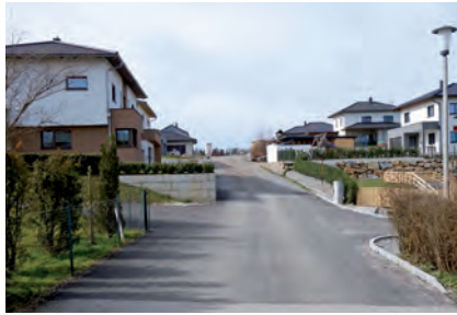
Vor der Asphaltierung wurden Randleisten gesetzt
