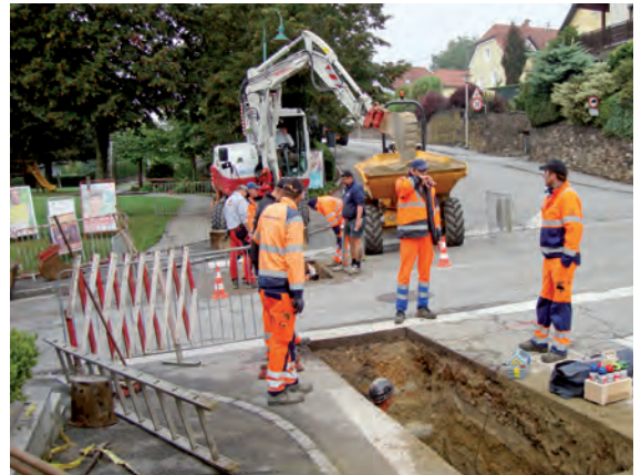
Die Arbeiten wurden von der Firma Swietelsky in Zusammenarbeit mit den Bauhofmitarbeitern durchgeführt
