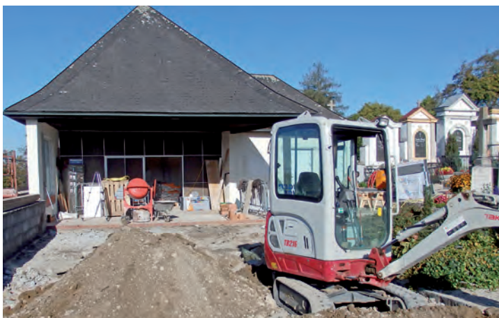
Baustelle am Friedhof
