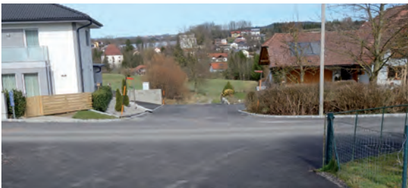
Asphaltierter Teilbereich am Ahornweg
