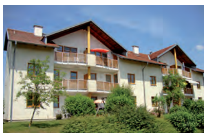
Wohnblock Sonnenhöhe 26 und 27
