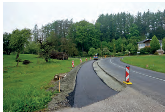
Die Asphaltierung des Gehweges erfolgte durch die Raaber Firma Felbermayr
