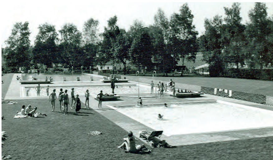
Schwimmbad in drei Becken aufgeteilt mit Wasseraufbereitungsanlage um 1974
