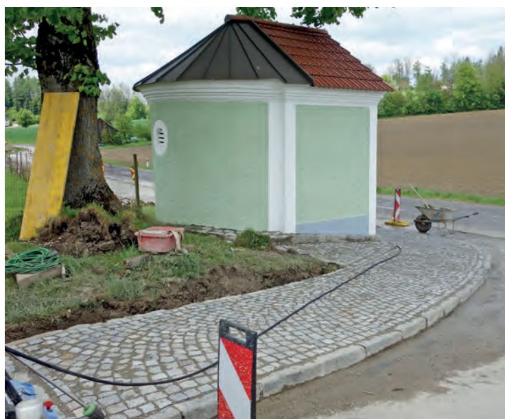
Im Zuge der Gehwegerrichtung wurde auch der Außenbereich der Pausinger Kapelle im Auftrag der Gemeinde neu gepflastert
